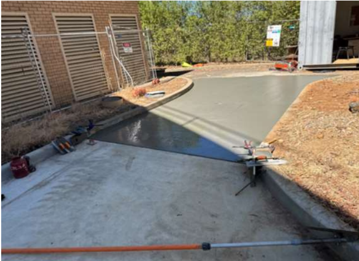
Photo – WTP final concrete pour.
